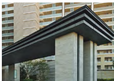
門廊屋簷／簷口飾板
